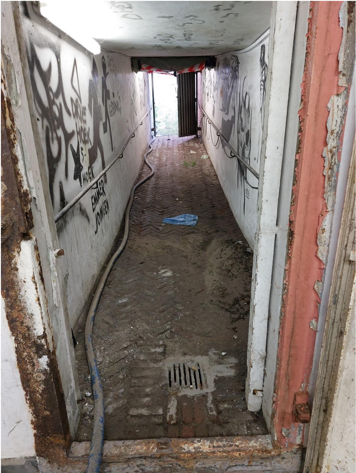
Figuur 2: Zicht vanuit het zuiden in de bunker op de oostelijke toegang (Bron: Monument Vandekerckhove Nv, 2024).
