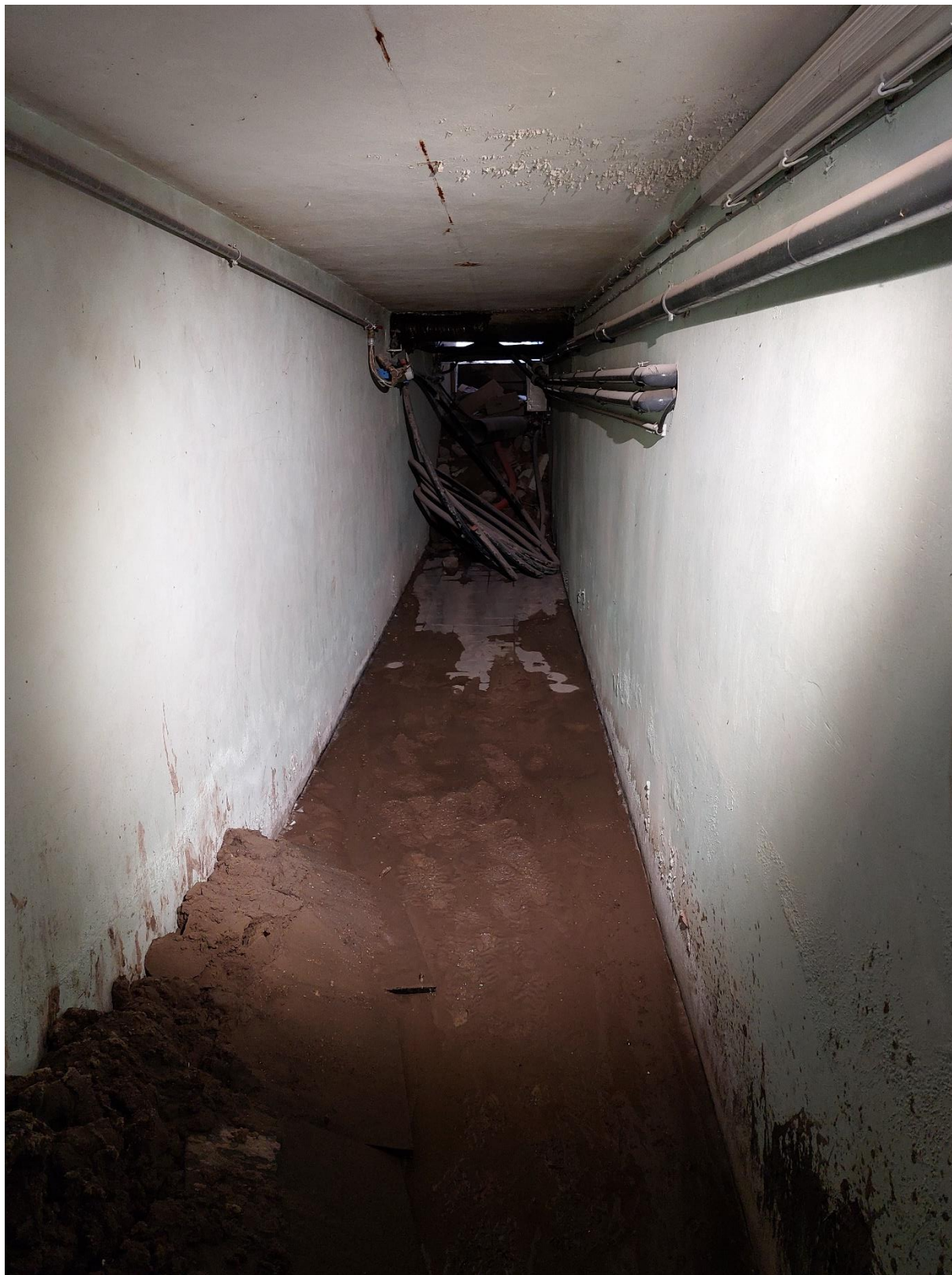
Figuur 3: Zicht vanuit het zuiden in de schuilbunker op de westelijke toegangstunnel. Slib komt bij regen binnen in deze gang (Bron: Monument Vandekerckhove Nv, 2024).
